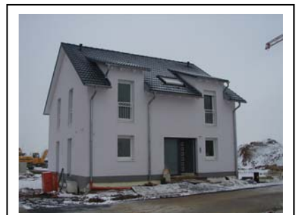
変わった屋根。緩い傾斜の屋根の雨樋からのパイプが下の屋根に直接落としていた。
