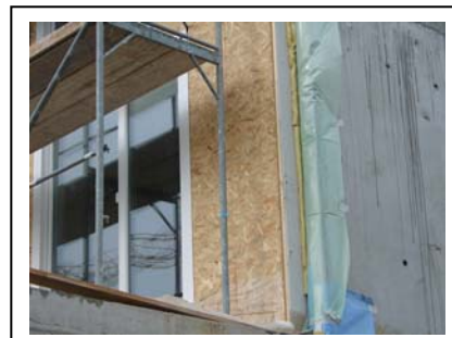
ロックウールと発泡系断熱材が覗ける
