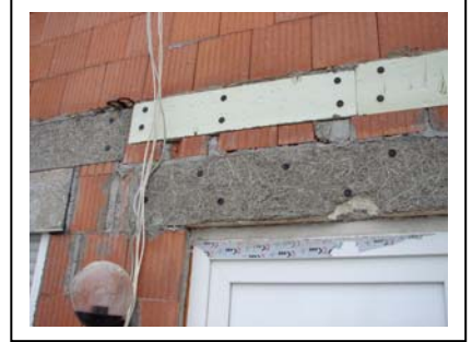
開口部の上部の窪みをブロックのレベルと合わせるために張った断熱材
