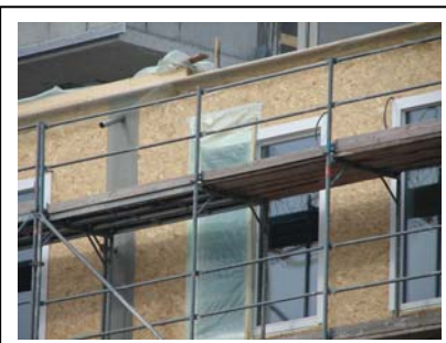
断熱材を覆った壁下地
