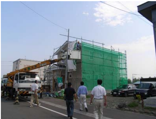
新濱建設 東川町現場
