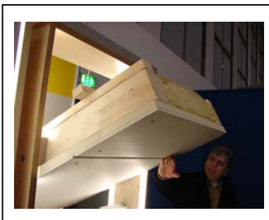
中: 屋根断熱の室内側に貼った発泡系断熱材
