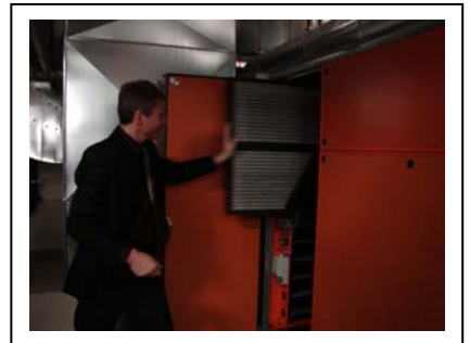
熱交換装置とフィルター素子
