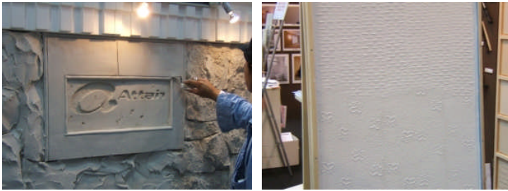
左:塗り壁で作った看板 右:スポンジローラーに切り込みをいれてころがした塗り壁パターン
