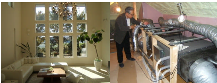
左:モデルハウス内部 右:杉並現場に設置された巨大な熱交換器(暖房、冷房)
